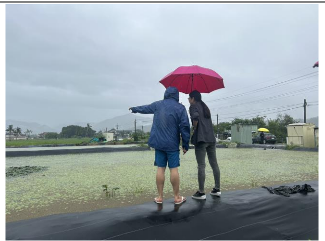
說明：現場確認施工影響範圍
