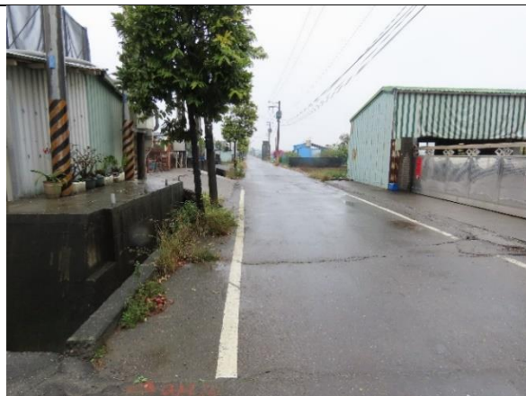
時間：114.2.10 說明：工區旁道路及房舍
