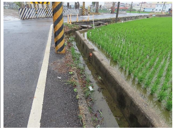
時間：114.2.10 說明：工區鄰近渠道現況
