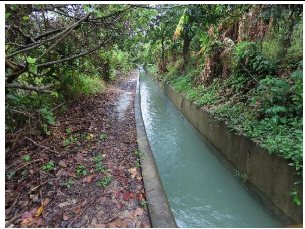
時間：114.2.13 說明：復興渠幹線現況
