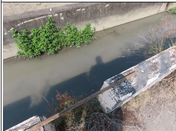
說明：工區二既有渠道現況
