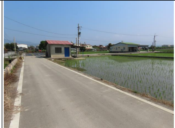
說明：工區二周邊既有道路
