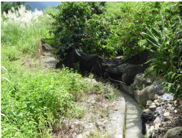
時間：113 年 9 月 11 日 說明：工區一預定地現況
