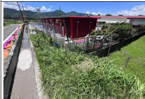
說明：工區三預定施作渠道現況
