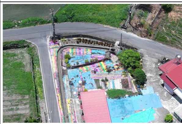
說明：工區三環境現況
