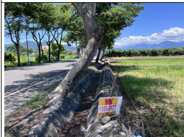
說明：工區二預定施作渠道現況
