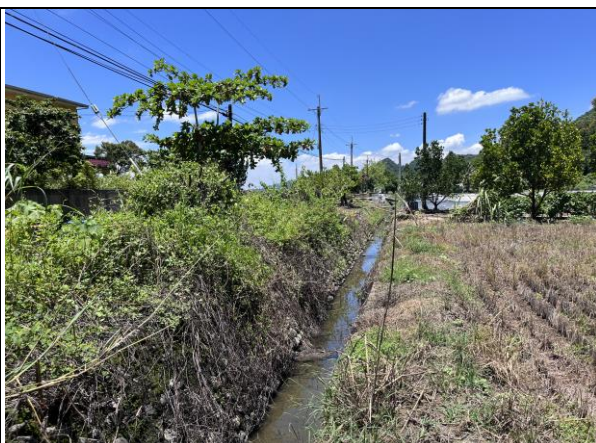
說明：工區一預定施作渠道現況
