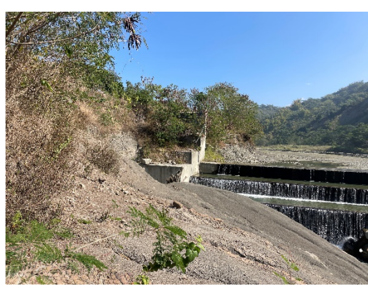
河道周邊現況 拍攝日期：113.1.30
