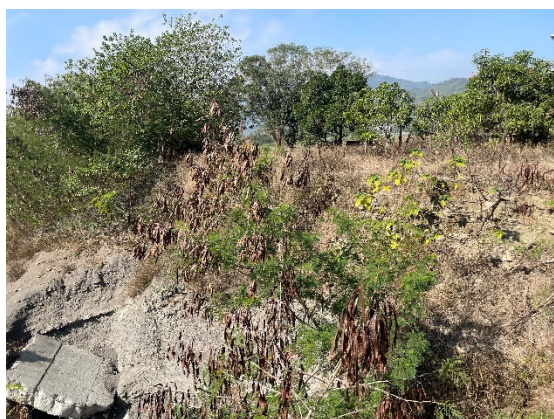
河道周邊現況 拍攝日期：113.1.30
