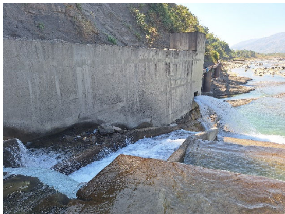
既有魚梯現況 拍攝日期：113.1.30
