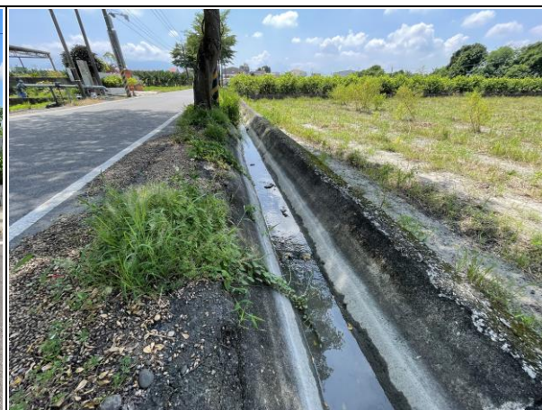
說明：工區一預定施作渠道現況
