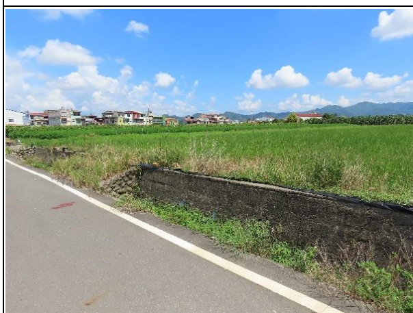
說明：工區二環境現況
