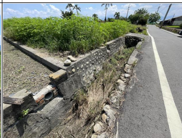
說明：工區二預定施作渠道現況
