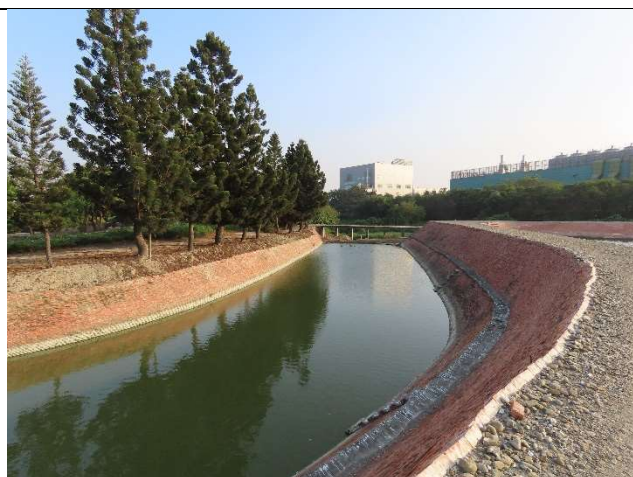
說明：紅磚護坡現場環境照
