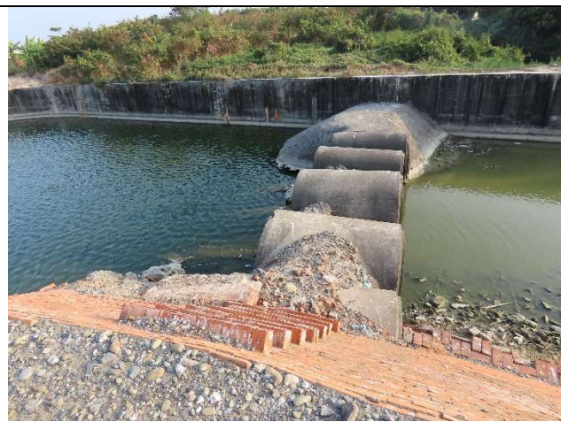
說明：過路涵管現場環境照
