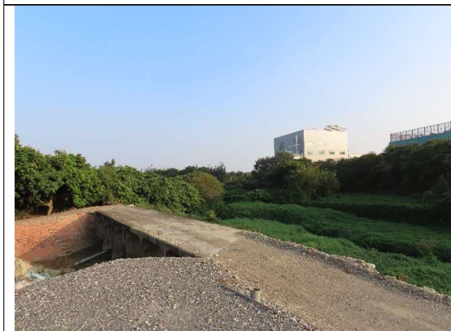
說明：擋水土堤現場環境照
