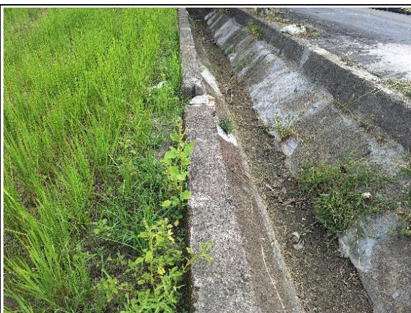
說明：工程預定地現況
