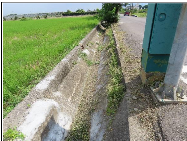
說明：工程預定地現況
