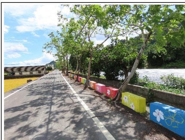
說明：工區一環境現況
