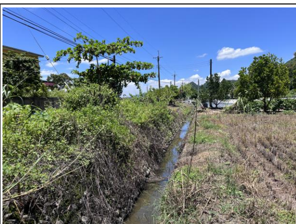
說明：工區一預定施作渠道現況
