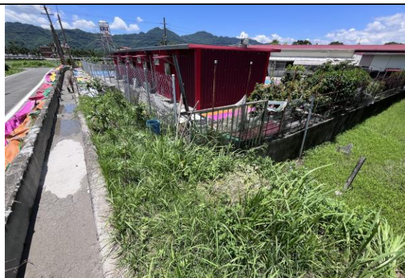
說明：工區三預定施作渠道現況
