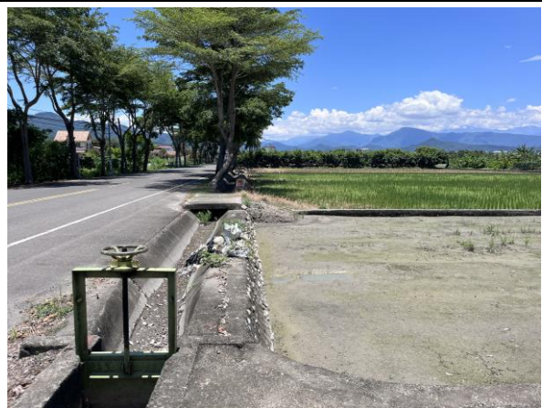
說明：工區二環境現況
