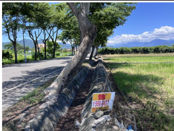
說明：工區二預定施作渠道現況
