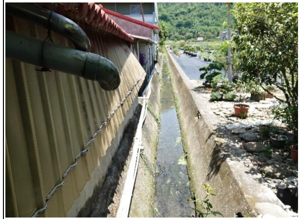
說明：工區一預計施作之渠道鄰近房舍
