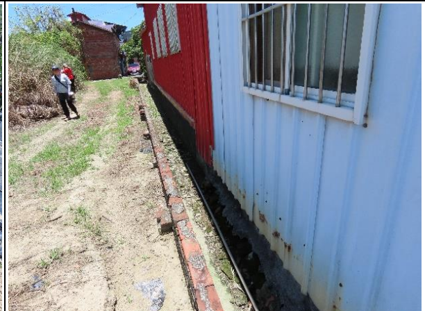
說明：工區二預計施作渠道現況
