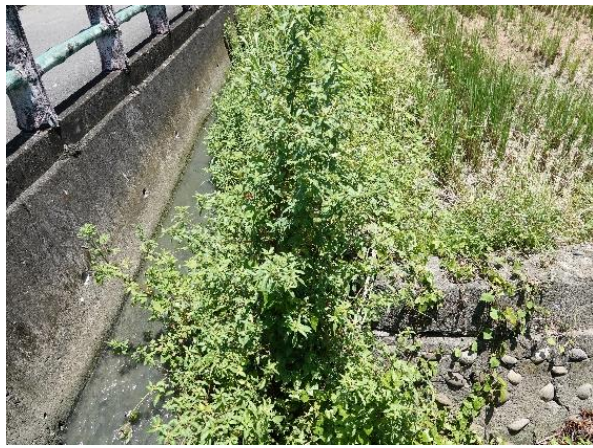
說明：工區一預計施作之渠道現況
