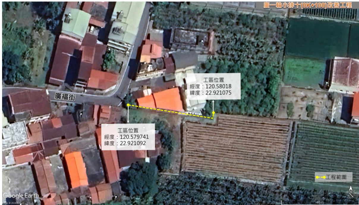
中八輪中排二之一(OK+130)等改善工程(工區二)
