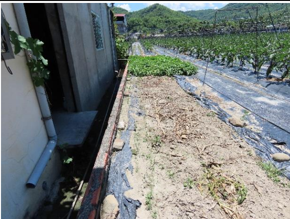
說明：工區二預計施作渠道現為磚塊砌成
